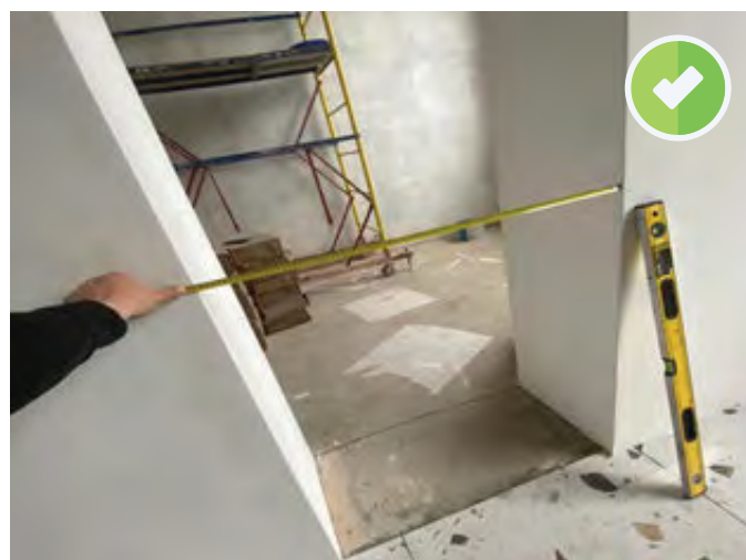
Готовый ровный проем для установки двери
