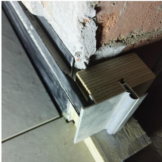
При установке скрытых дверей алюминиевый профиль скрытого плинтуса может монтироваться как до так или после крепления короба к стене.
