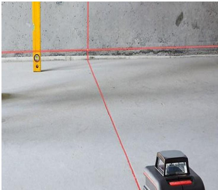
Перед началом монтажа алюминиевого профиля необходимо **определить точный уровень чистового пола.**
